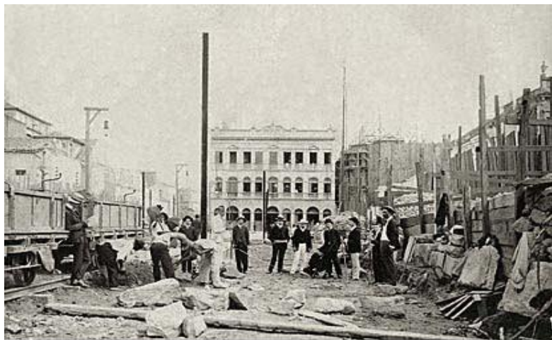
Demolições para a construção da avenida Central, 1904-1905 João Martins Torres – Acervo Instituto Moreira Salles
