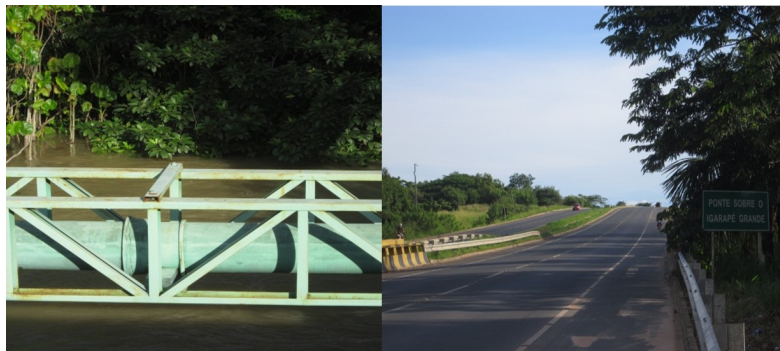
Foto 3 e 4: Ponte sobre o Igarapé Grande, na BR 174, em 2012
