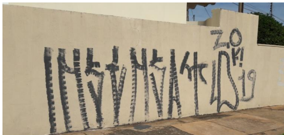
Figura 1: Pixação em parede residencial, localizada da Avenida Júlio de Castilho 4 .
