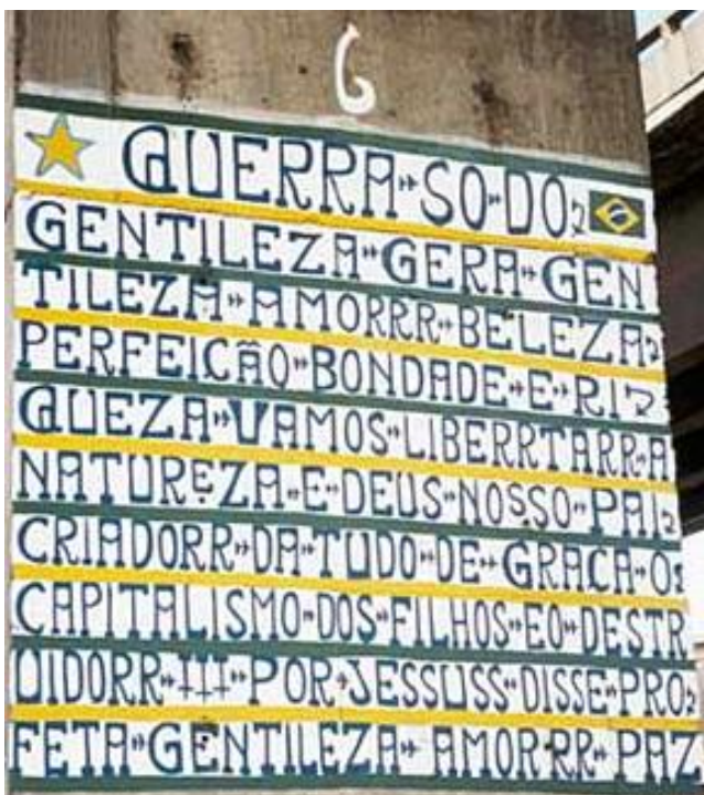
FIG. 4: FOTO DA PILASTRA 6
