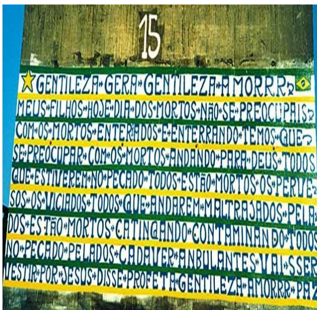
FIG. 2: FOTO DA PILASTRA 15
