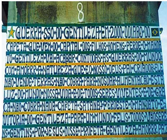
FIG. 7: FOTO DA PILASTRA 8
